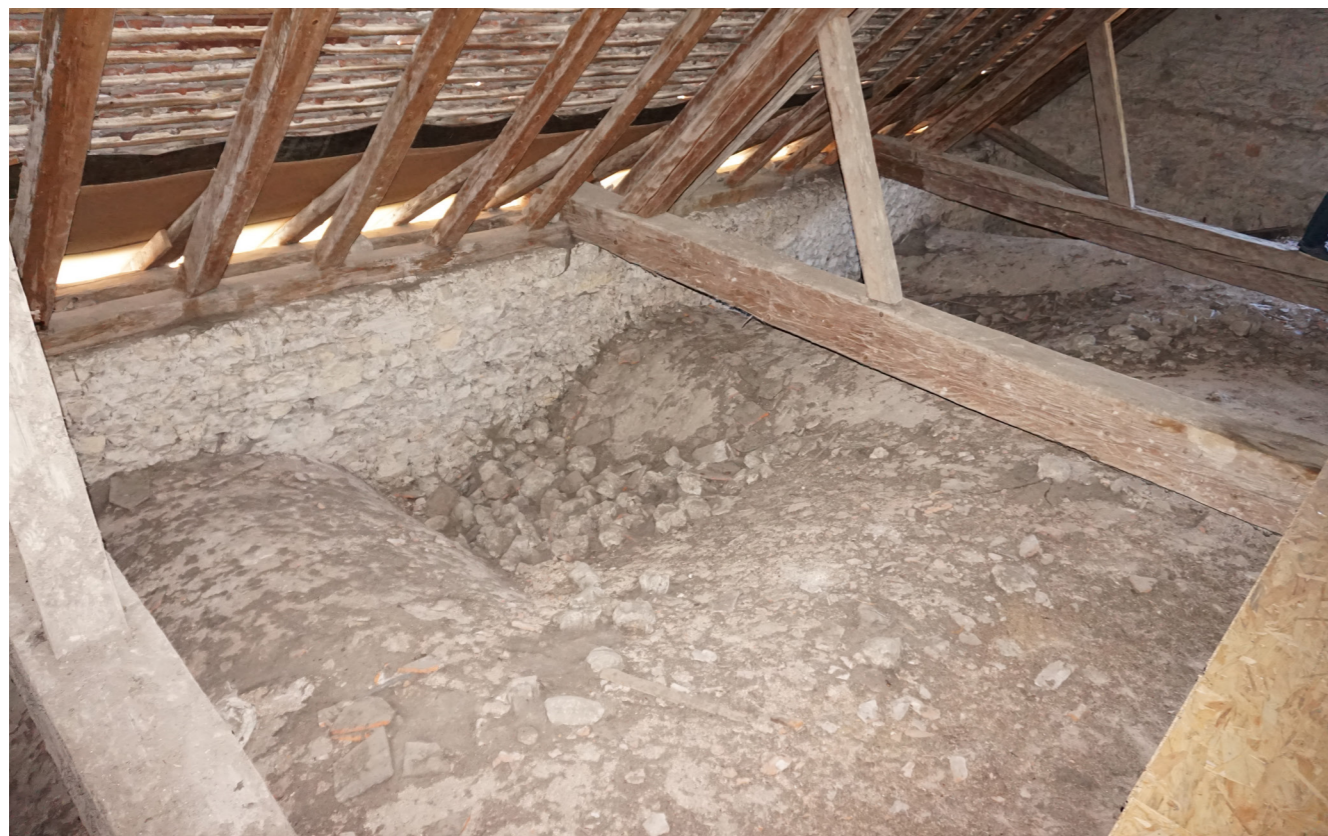
PHOTO DE LA CHARPENTE ET DES VOÛTES - AGENCE C. REMOND - AOUT 2018
