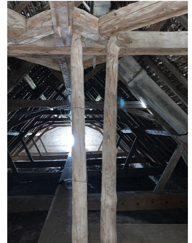
RENFORCEMENT POINÇON EN PARTIE HAUTE ET BASSE (AUCUNE REPRISE DES CHARGES) - AGENCE C. REMOND - AVRIL 2020
