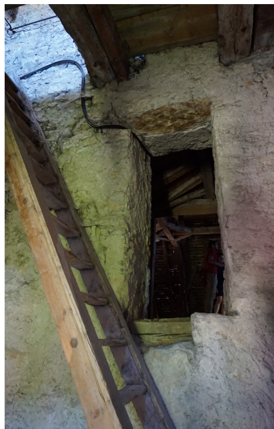
PHOTO DE L'INTÉRIEUR DU CLOCHER- AGENCE C. REMOND - AOUT 2018
