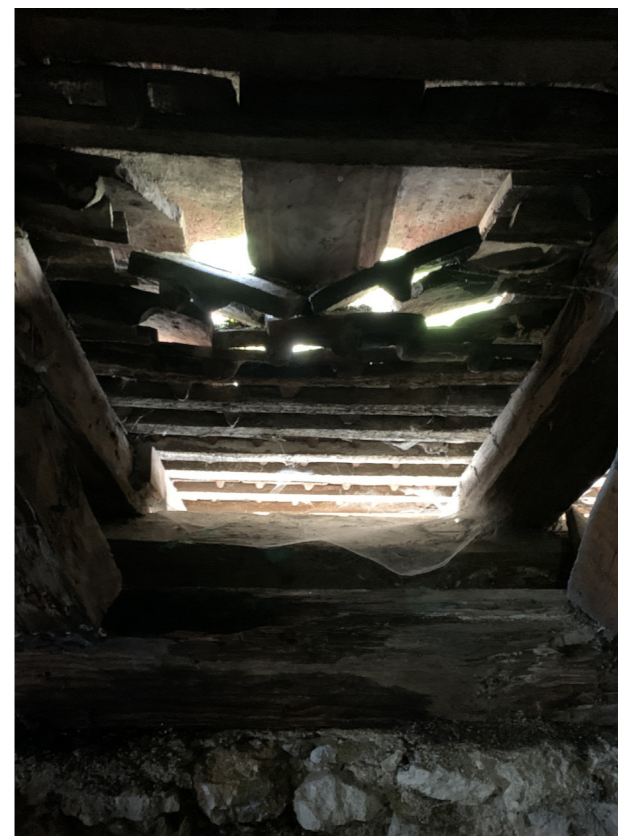
SABLIÈRE DÉFAILLANTE / RENFORCEMENT COYAUX - 3ÈME TRAVÉE NORD - AGENCE C. REMOND - AVRIL 2020
