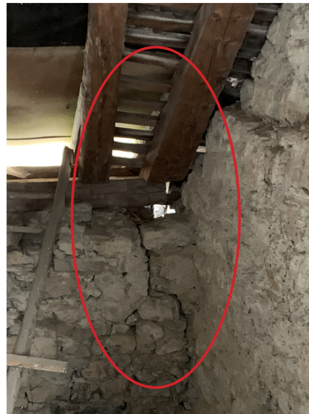
APPUI SUR SABLIERE DÉFAILLANTS / PIERRES DÉJOINTÉES / FISSURES - 1ER TRAVÉE SUD - AGENCE C. RÉMOND - AVRIL 2020
