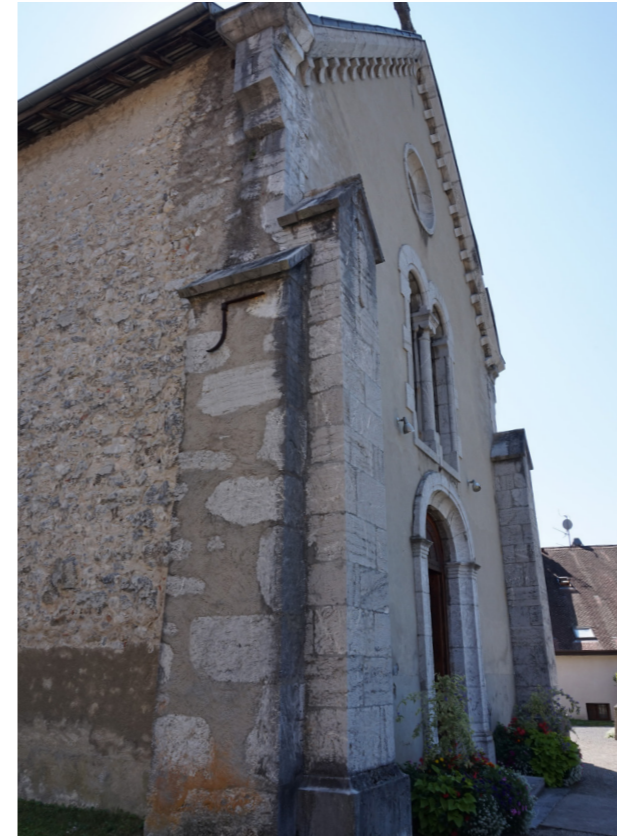
FAÇADE OUEST - ZOOM CONTREFORT - PHOTO AVRIL 2019, CR
