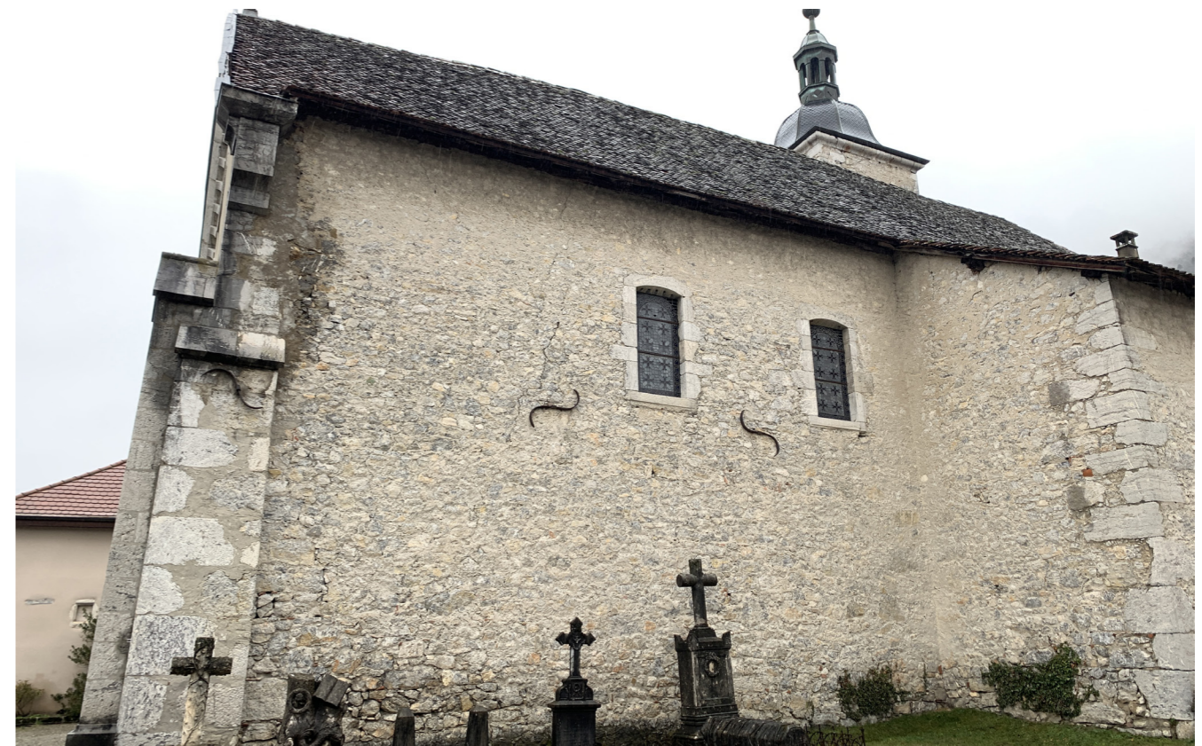
PHOTO DE LA FAÇADE NORD DE L'ÉGLISE - AGENCE C. RÉMOND - JANVIER 2020
