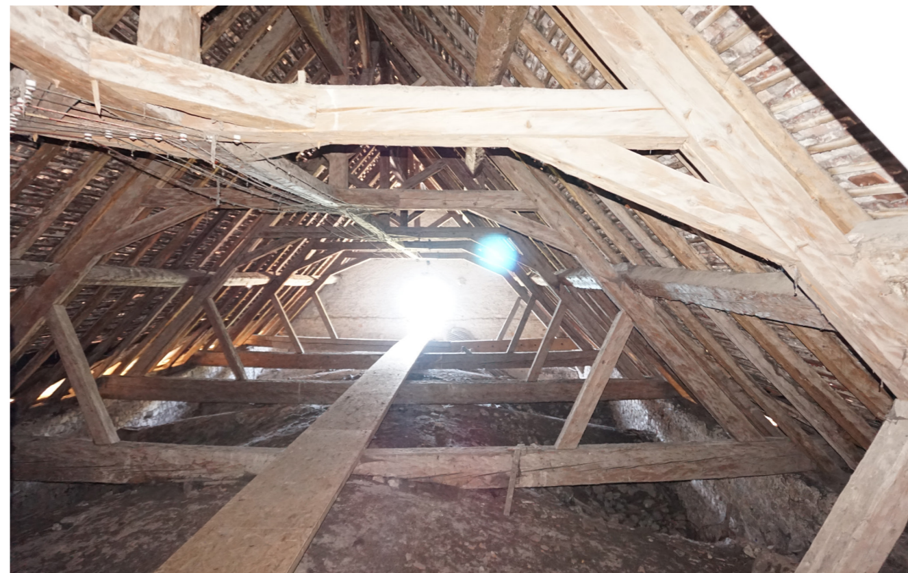
PHOTO DE LA CHARPENTE DE L'ÉGLISE AU DESSUS DE LA NEF - AGENCE C. REMOND - AOUT 2018
