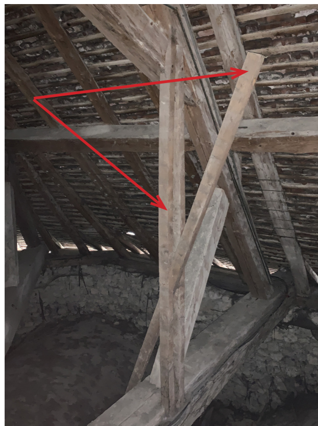
AJOUT DES BOIS DE SUPPORT SANS AUCUNE REPRISE DES CHARGES - 6ÈME FERME SUD ET NORD - AGENCE C. REMOND - AVRIL 2020
