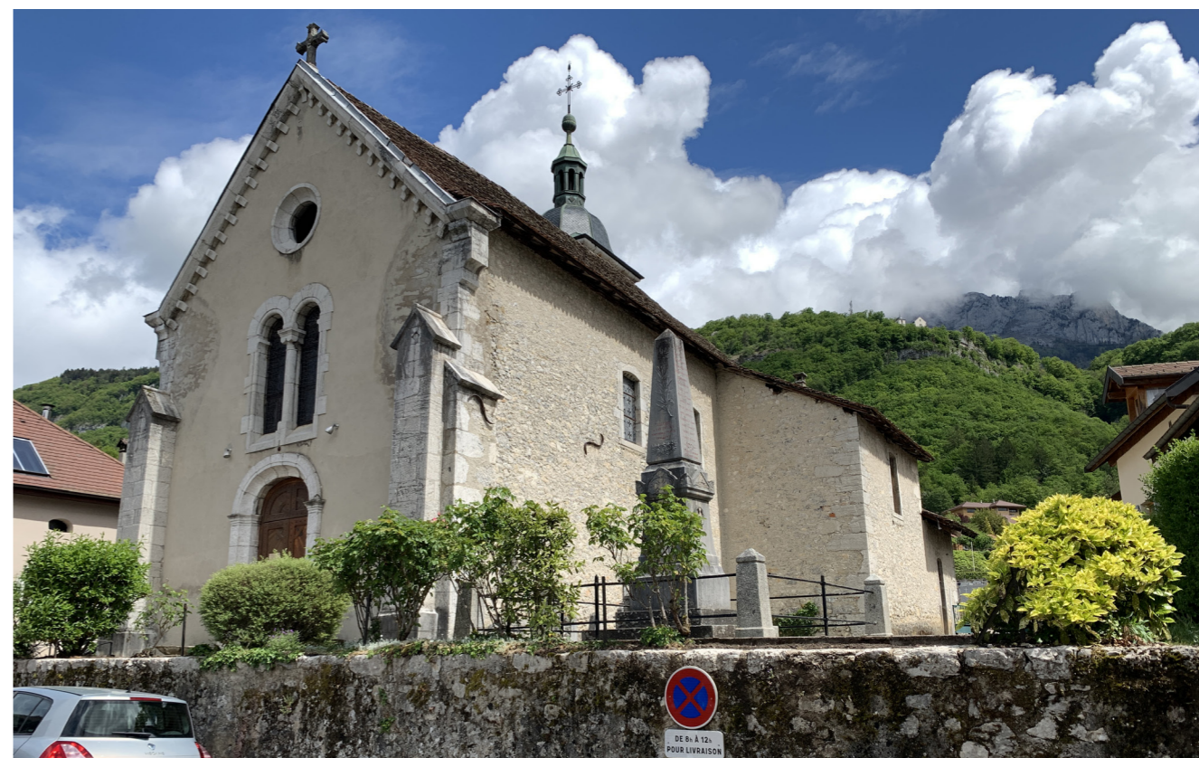
PHOTO DES DÉSORDRES LIÉS À L'HUMIDITÉ - AGENCE C. RÉMOND - AVRIL 2020
