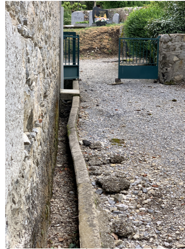
CANIVEAU EN PIED DE MUR - AGENCE C. REMOND - AVRIL 2020
