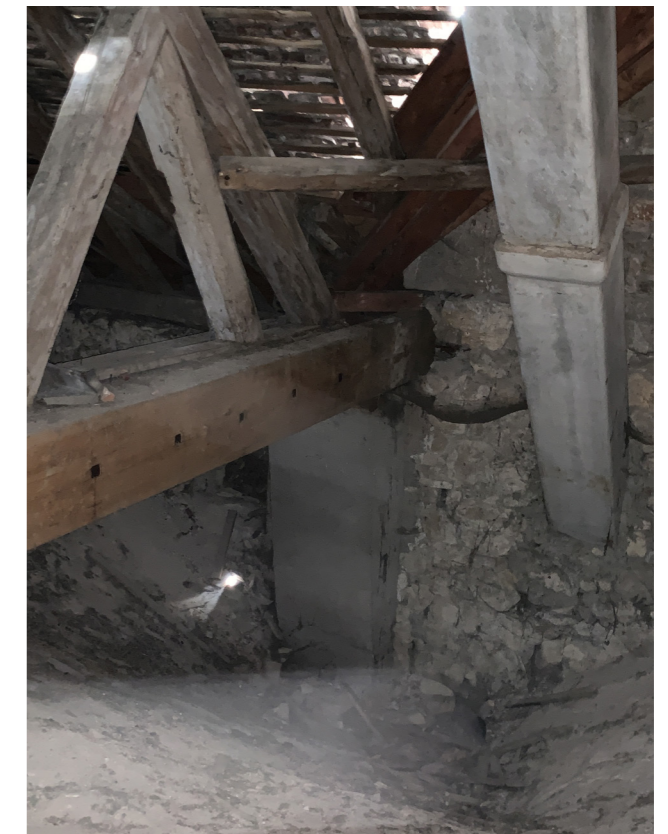
CRÉATION D'UNE PILE EN BÉTON SUR LAQUELLE REPOSE L'ENTRAIN - 5ÈME FERME NORD - AGENCE C. RÉMOND - AVRIL 2020
