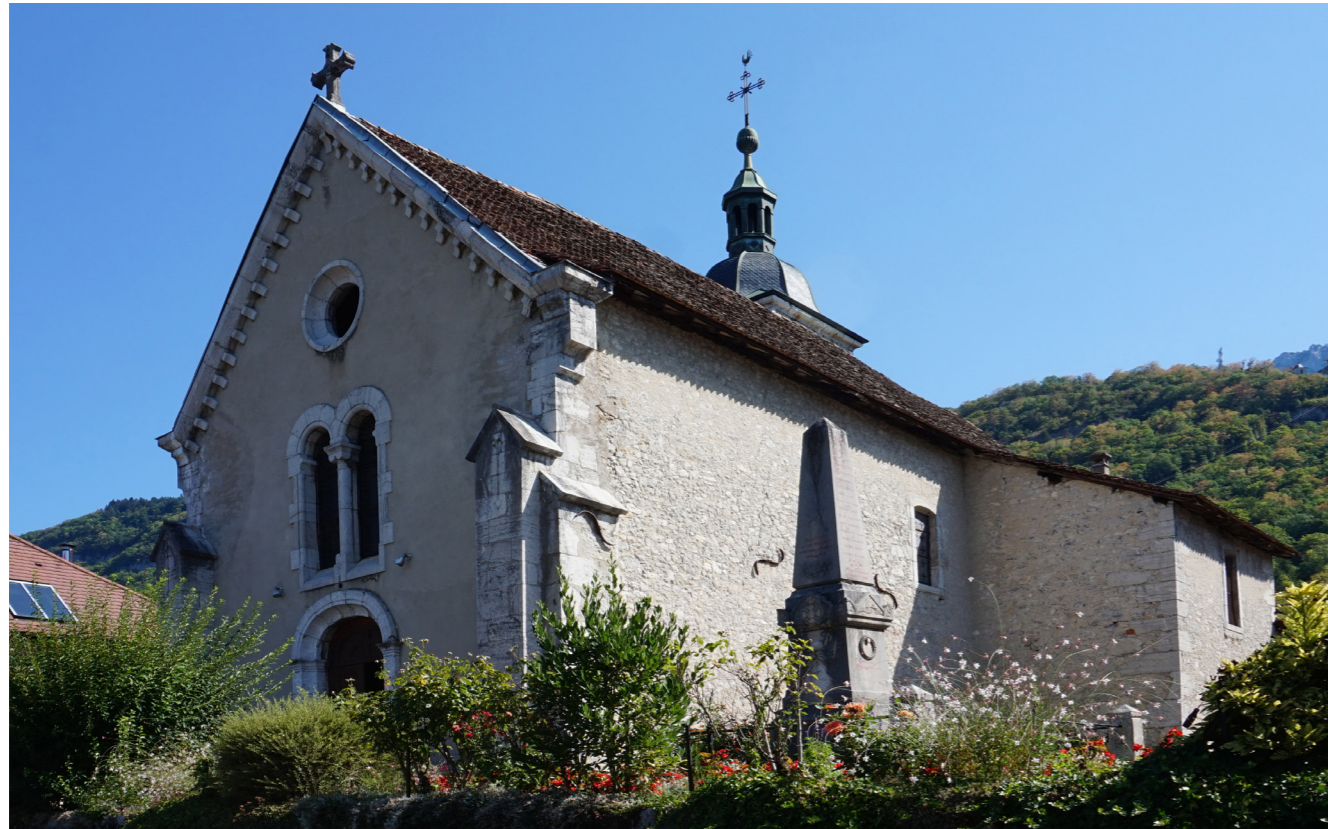
VUE SUD-OUEST DE LA FAÇADE PRINCIPALE ET DE LA FAÇADE LATÉRALE SUD (AGENCE CECILE REMOND)
