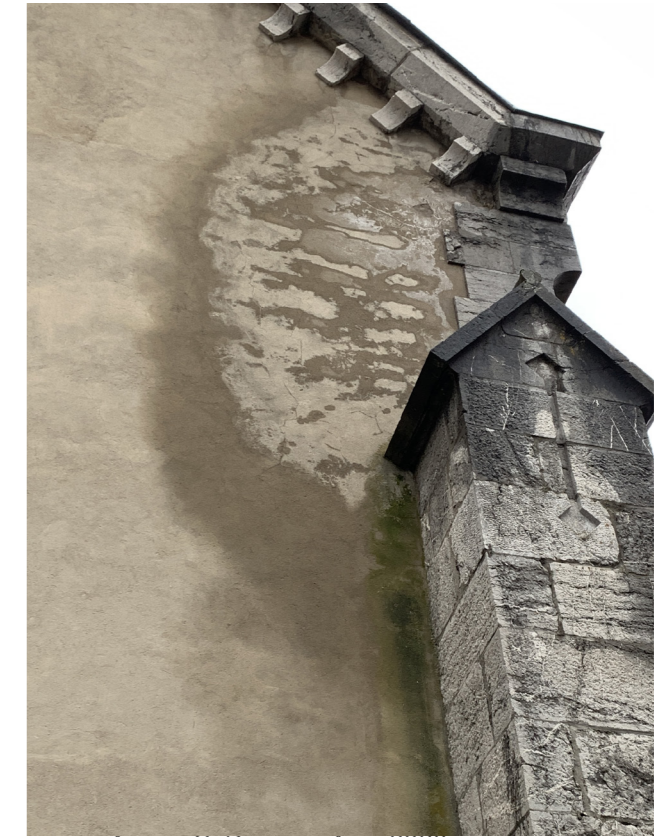
COLONISATIONS BIOLOGIQUES ET REMONTÉES CAPILLAIRES SUR L'ARMER ET FAÇADE - AGENCE C. REMOND - AVRIL 2020
