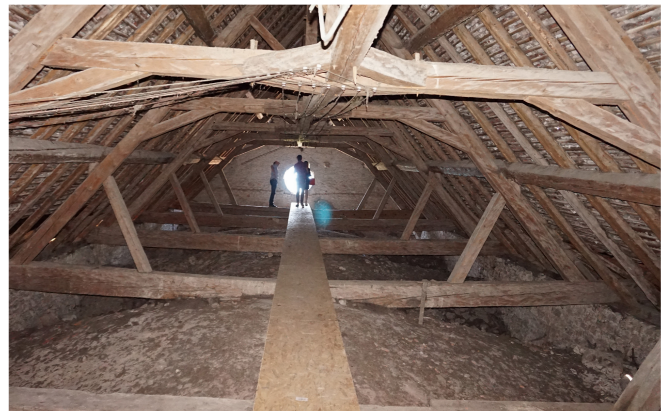
VUE DE LA CHARPENTE - PHOTO AVRIL 2019, CR
