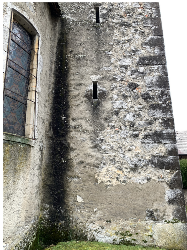
COLONISATION BIOLOGIQUE DE L'ANGLE NORD-OUEST ET REMONTÉES CAPILLAIRES / CANIVEAU AU SOL - AGENCE C. REMOND - AVRIL 2020
