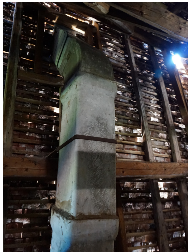
MAUVAISE REPRISE DES BOIS SUITE AU PASSAGE DE LA CONDUITE DE CHEMINÉE - 6ÈME TRAVÉE NORD - AGENCE C. RÉMOND - AVRIL 2020
