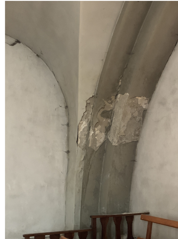
MAÇONNERIE ET ENDUIT DÉGRADÉS AU NIVEAU DE L'ARC DOUBLON - 1ERE TRAVÉE - VUE DEPUIS LA TRIBUNE - AGENCE C. REMOND - AVRIL 2020
