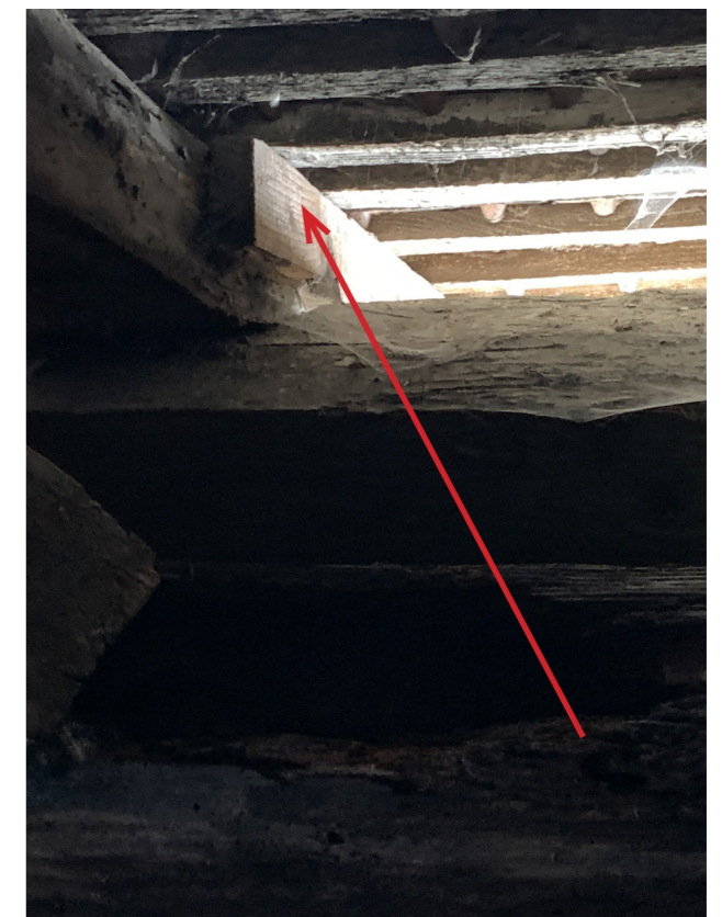
SABLIÈRE DÉFAILLANTE / RENFORCEMENT COYAUX - 3ÈME TRAVÉE NORD - AGENCE C. REMOND - AVRIL 2020
