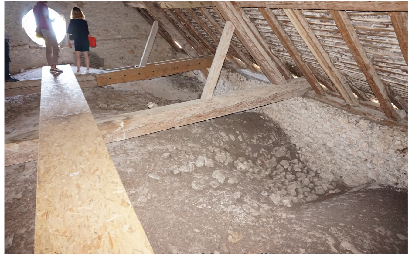
PHOTO DE LA CHARPENTE DE L'ÉGLISE AU NIVEAU DE LA NEF - AGENCE C. REMOND - AOUT 2018
