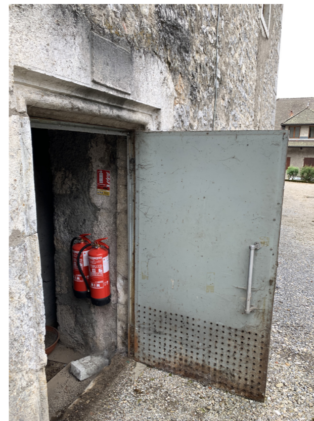
PORTE D'ENTRÉE ALA CHAUFFERIE - AGENCE C. REMOND - AVRIL 2020
