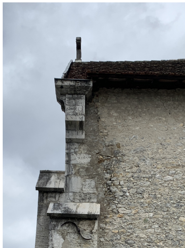
COLONISATION BIOLOGIQUE DE L'ANGLE NORD-OUEST ET REMONTÉES CAPILLAIRES - AGENCE C. REMOND - AVRIL 2020
