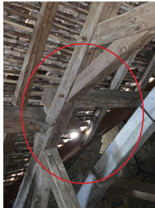
MAUVAISE REPRISE DES BOIS SUITE AU PASSAGE DE LA CONDUITE DE CHEMINÉE - 6ÈME TRAVÉE NORD - AGENCE C. RÉMOND - AVRIL 2020
