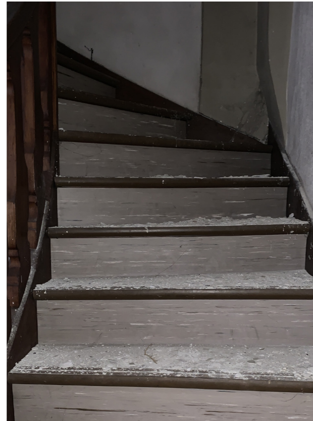
ESCALIER ACCÈS TRIBUNE- AGENCE C. REMOND - AVRIL 2020
