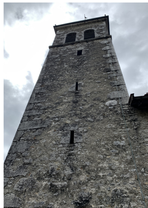
PHOTO DES DÉSORDRES LIÉS À L'HUMIDITÉ ET AUX TRACES D'ENDUIT CIMENT - AGENCE C. REMOND - AVRIL 2020
