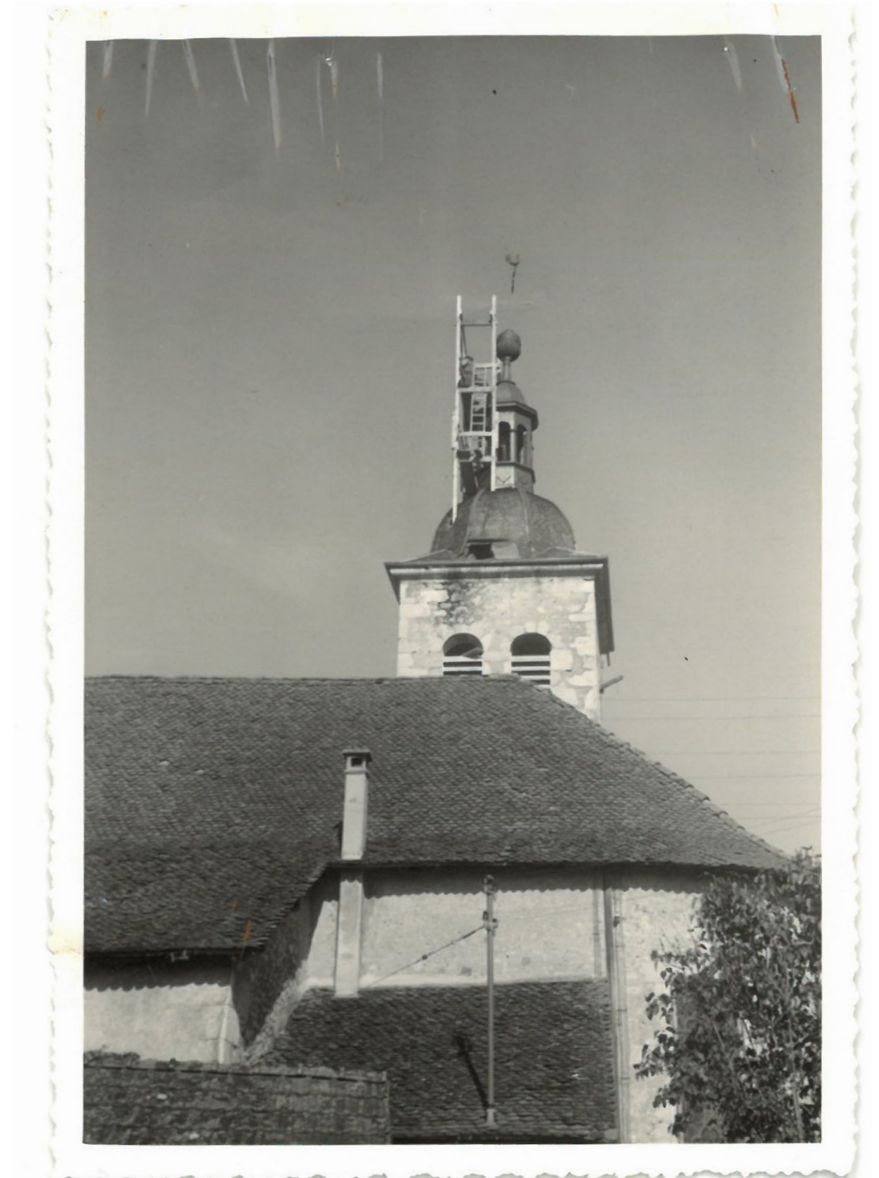
AMT, PHOTO PRISE AVANT LA DÉPOSE DE LA CROIX QUI MENAÇAIT DE TOMBER SUR LA TOITURE DE L'ÉGLISE, JANVIER 1967
