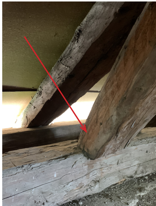
APPUI SUR SABLIERE DÉFAILLANTS / PIERRES DÉJOINTÉES / FISSURES - 1ER TRAVÉE SUD - AGENCE C. RÉMOND - AVRIL 2020
