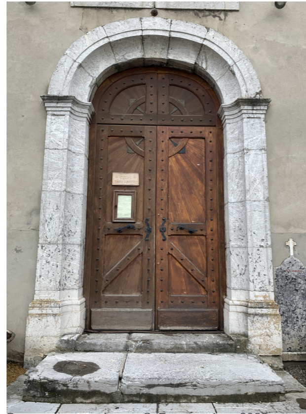
PORTAL D'ENTRÉE - AGENCE C. REMOND - AVRIL 2020
