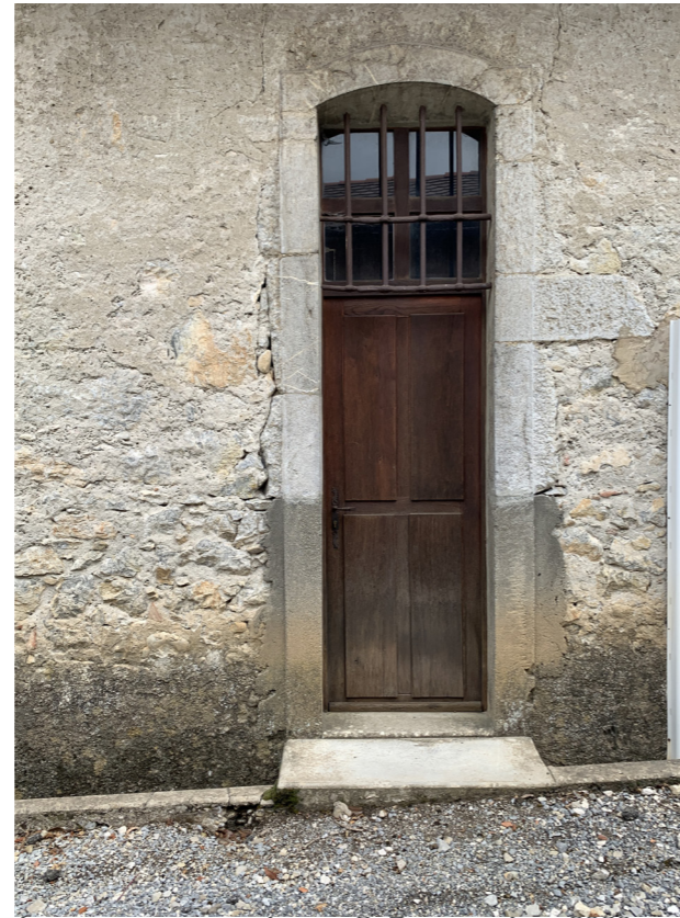
ACCÈS A LA SACRISTIE - AGENCE C. REMOND - AVRIL 2020
