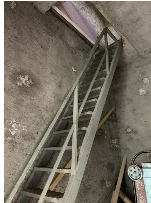
ENDUIT CIMENT - CHAUFFERIE - AGENCE C. REMOND - AVRIL 2020
