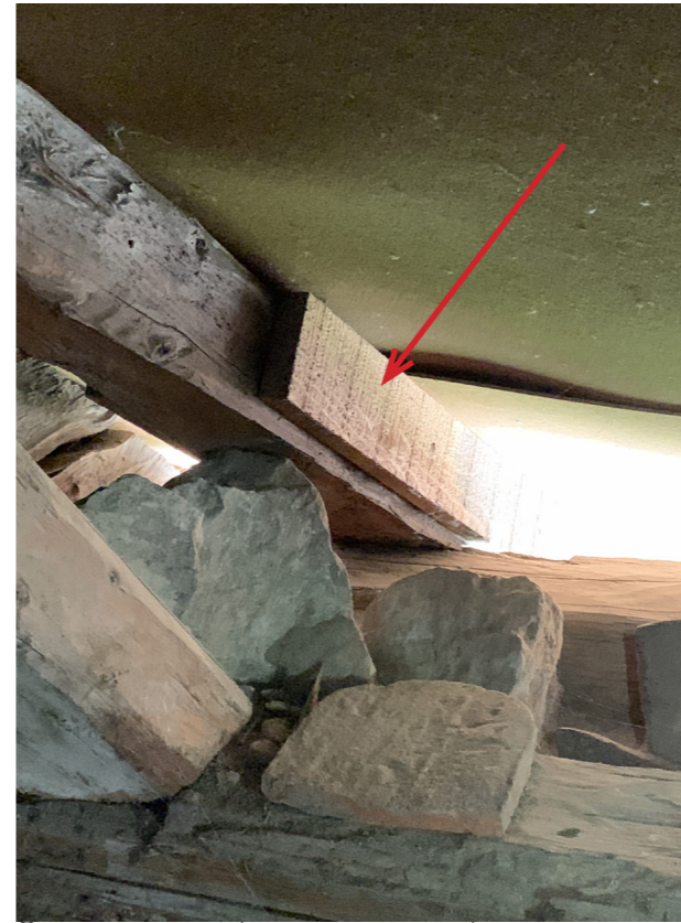
COYAUX RENFORCÉS / PIERRES DÉJOINTÉES / MEMBRANE ÉTANCHE EN MAUVAIS ÉTAT - 2ÈME TRAVÉE SUD - AGENCE C. REMOND - AVRIL 2020
