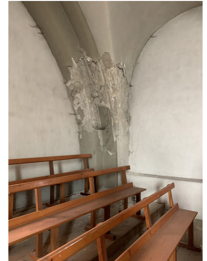
MAÇONNERIE ET ENDUIT DÉGRADÉS AU NIVEAU DE L'ARC DOUBLON - 1ERE TRAVÉE - VUE DEPUIS LA TRIBUNE - AGENCE C. REMOND - AVRIL 2020
