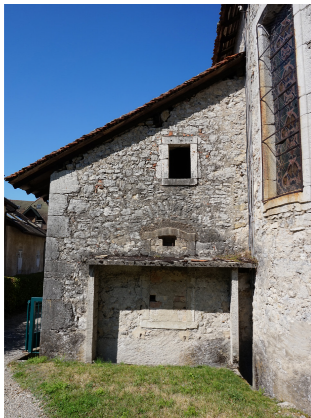
FAÇADE SUD - ANNEXE - PHOTO AVRIL 2019, CR
