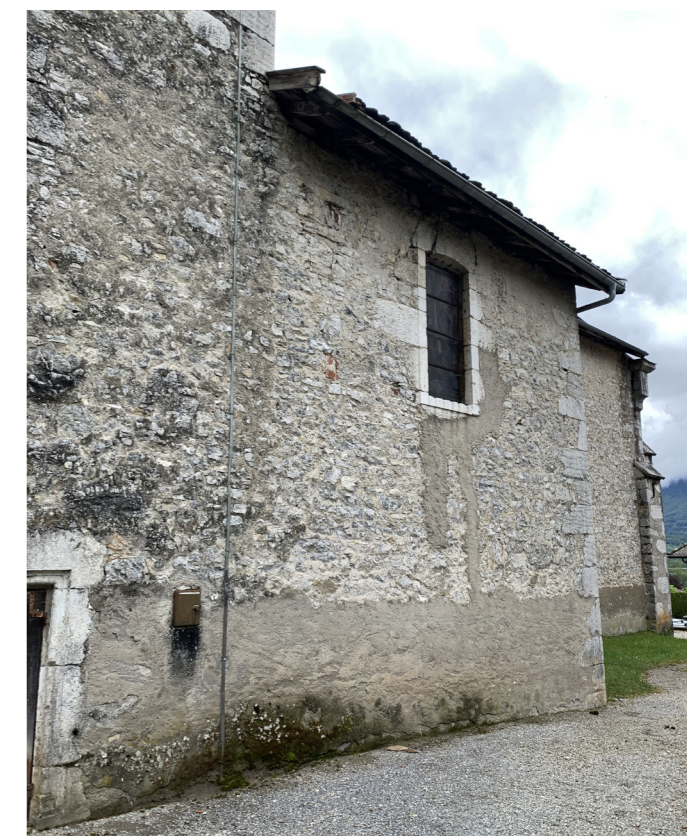
PHOTO DES DÉSORDRES LIÉS À L'HUMIDITÉ ET AUX TRACES D'ENDUIT CIMENT - AGENCE C. REMOND - AVRIL 2020
