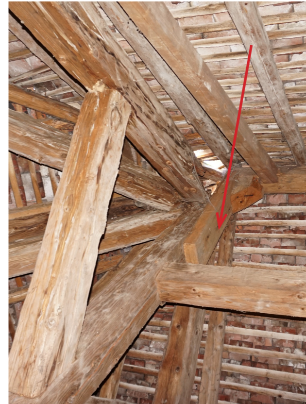
RENFORCEMENT POINÇON EN PARTIE HAUTE ET BASSE (AUCUNE REPRISE DES CHARGES) - AGENCE C. REMOND - AVRIL 2020
