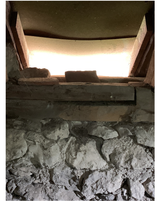
COYAUX RENFORCÉS / PIERRES DÉJOINTÉES / MEMBRANE ÉTANCHE EN MAUVAIS ÉTAT - 2ÈME TRAVÉE SUD - AGENCE C. REMOND - AVRIL 2020
