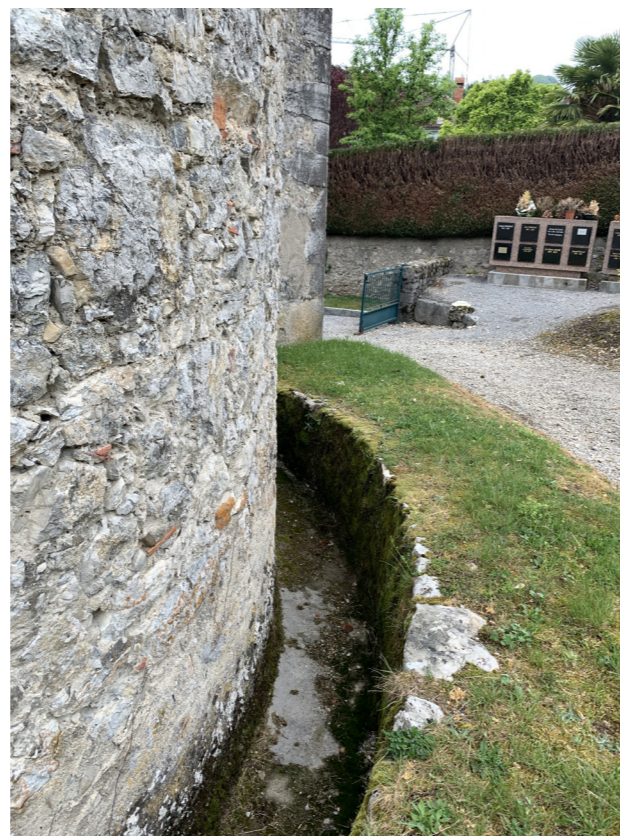
COLONISATION BIOLOGIQUE DE L'ANGLE NORD-OUEST ET REMONTÉES CAPILLAIRES / CANIVEAU AU SOL - AGENCE C. REMOND - AVRIL 2020
