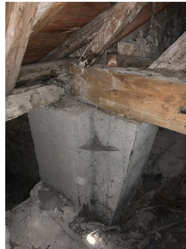
CRÉATION D'UNE PILE EN BÉTON SUR LAQUELLE REPOSE L'ENTRAIN - 5ÈME FERME NORD - AGENCE C. RÉMOND - AVRIL 2020
