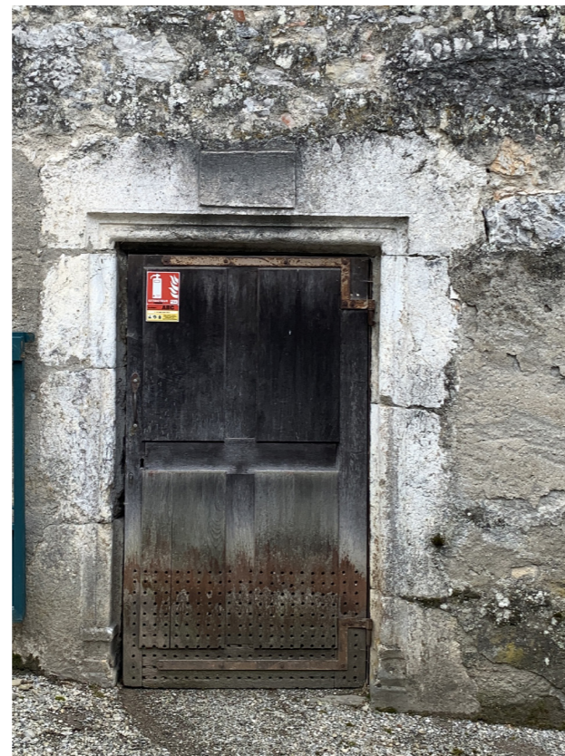
PORTE D'ACCÈS A LA CHAUFFERIE - AGENCE C. REMOND - AVRIL 2020
