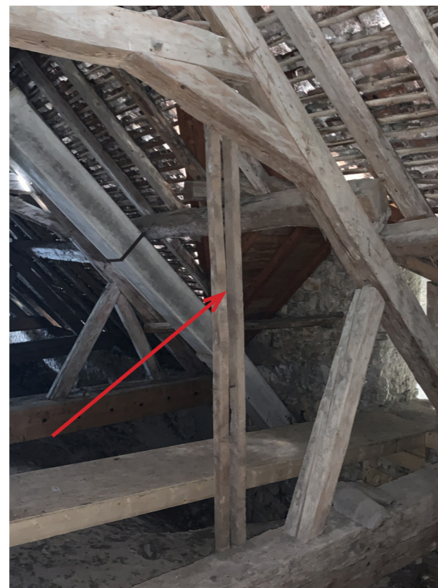
AJOUT DES BOIS DE SUPPORT SANS AUCUNE REPRISE DES CHARGES - 6ÈME FERME SUD ET NORD - AGENCE C. REMOND - AVRIL 2020
