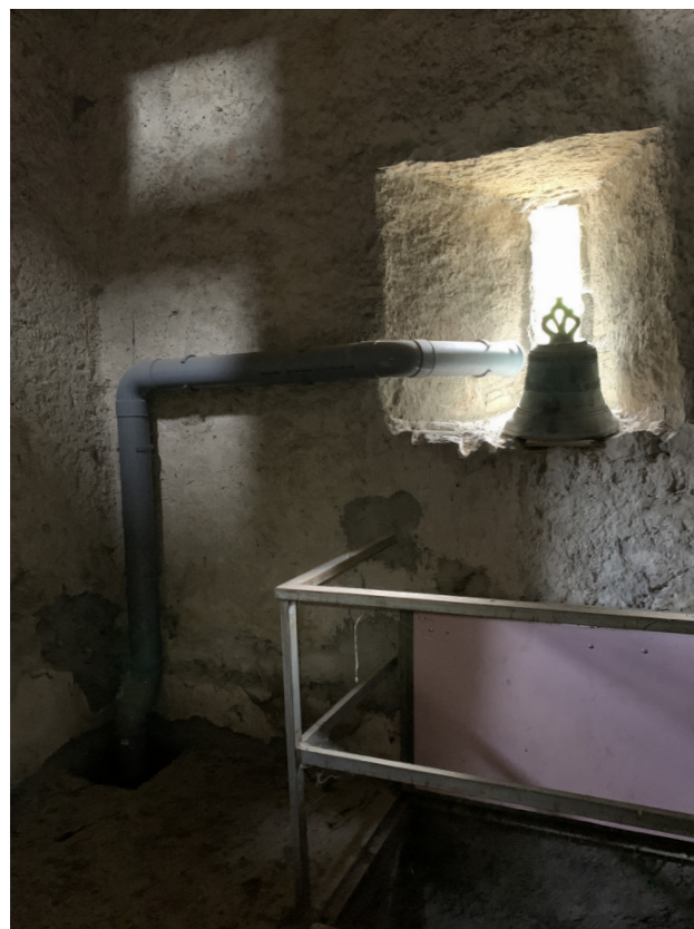
GARDE-CORPS SCELLÉ AVEC DU CIMENT - AGENCE C. REMOND - AVRIL 2020
