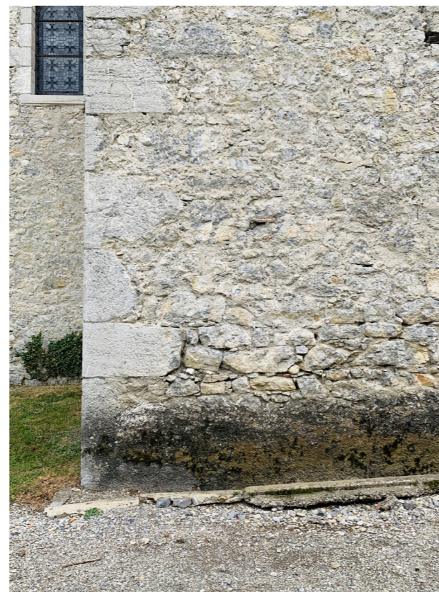
COLONISATION BIOLOGIQUE DE L'ANGLE NORD-OUEST ET REMONTÉES CAPILLAIRES - AGENCE C. REMOND - AVRIL 2020
