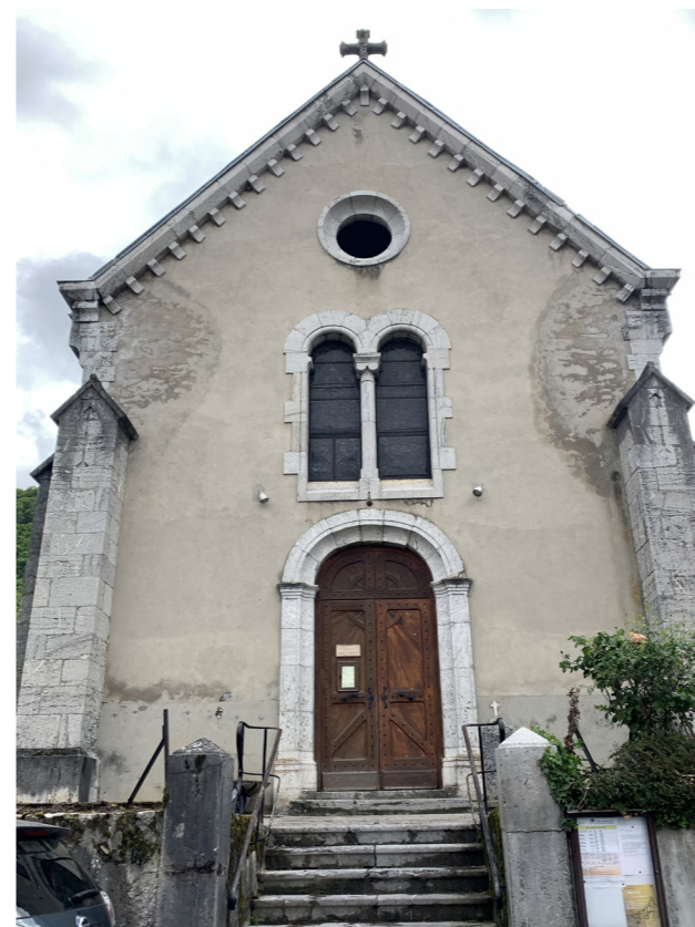
PHOTO DE LA FAÇADE OUEST DE L'ÉGLISE - AGENCE C. RÉMOND - JANVIER 2020
