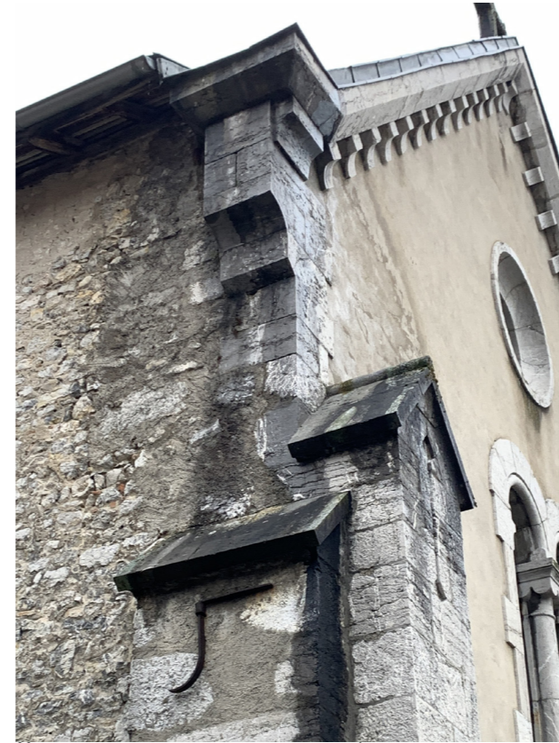
COLONISATIONS BIOLOGIQUES ET REMONTÉES CAPILLAIRES SUR L'ARMER ET FAÇADE - AGENCE C. REMOND - AVRIL 2020
