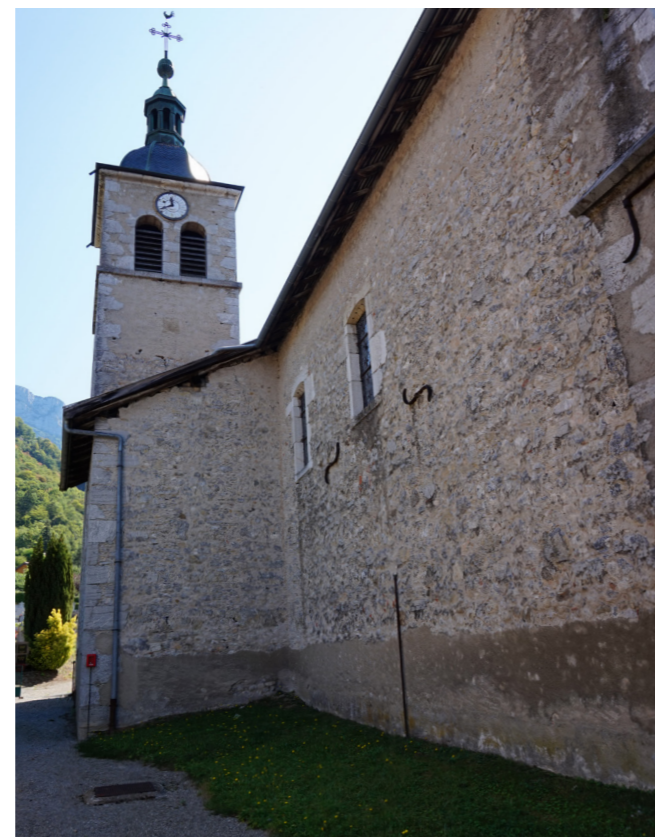
FAÇADE NORD - TRANSEPT - PHOTO AVRIL 2019, CR
