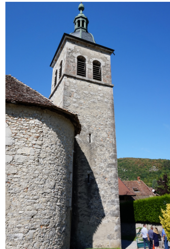
FAÇADE EST - CLOCHER - PHOTO AVRIL 2019, CR
