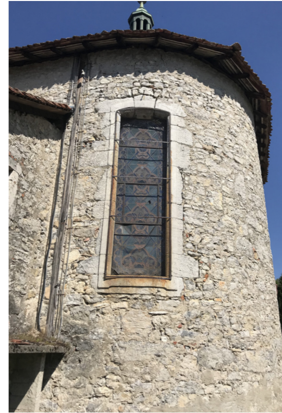
FAÇADE NORD - ZOOM BAIE CHEVET - PHOTO AVRIL 2019, CR
