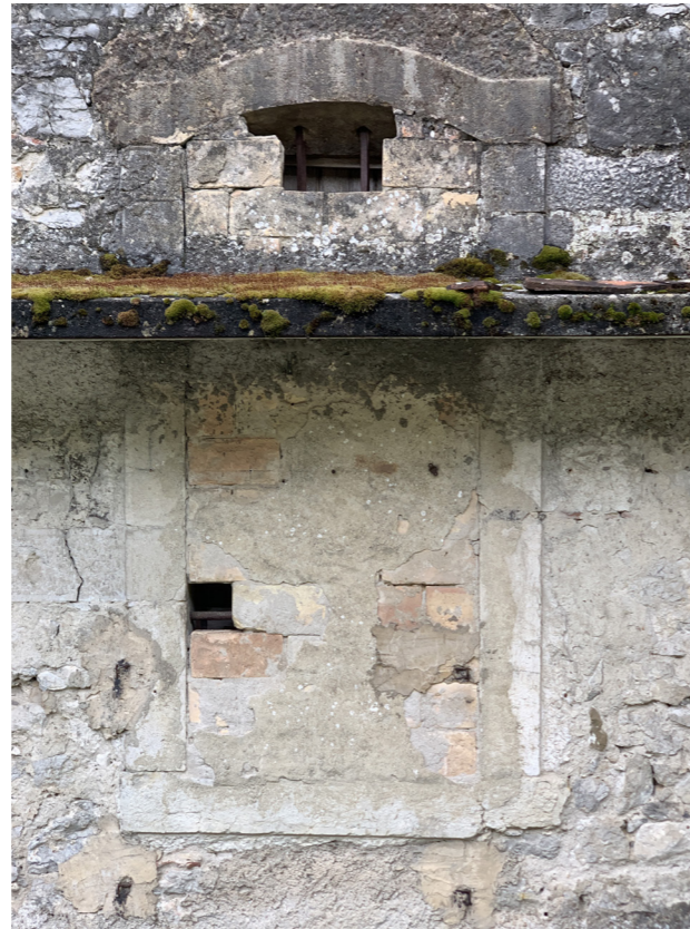
BAIE BOUCHÉE - AGENCE C. REMOND - AVRIL 2020
