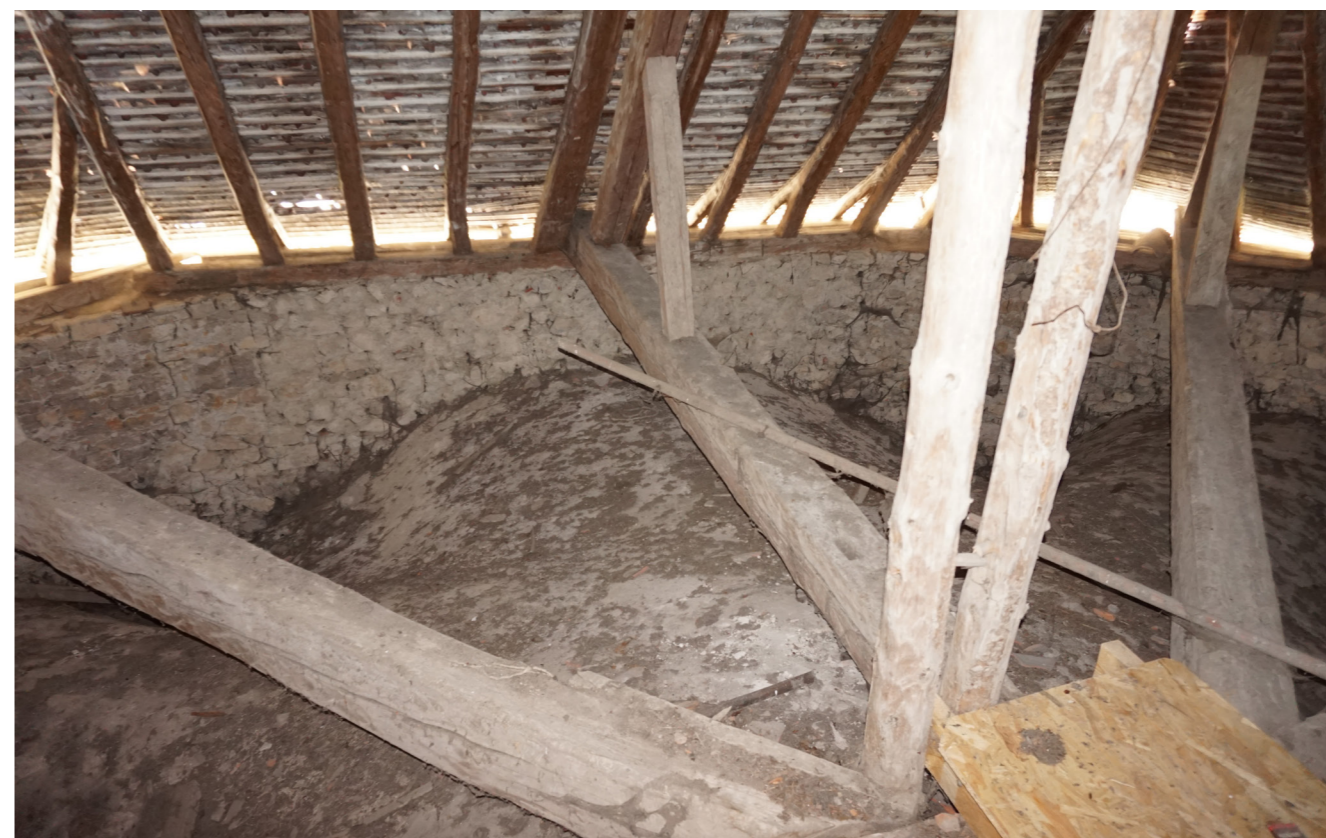
PHOTO DE LA CHARPENTE DE L'ÉGLISE AU NIVEAU DU CHEVET - AGENCE C. REMOND - AOUT 2018
