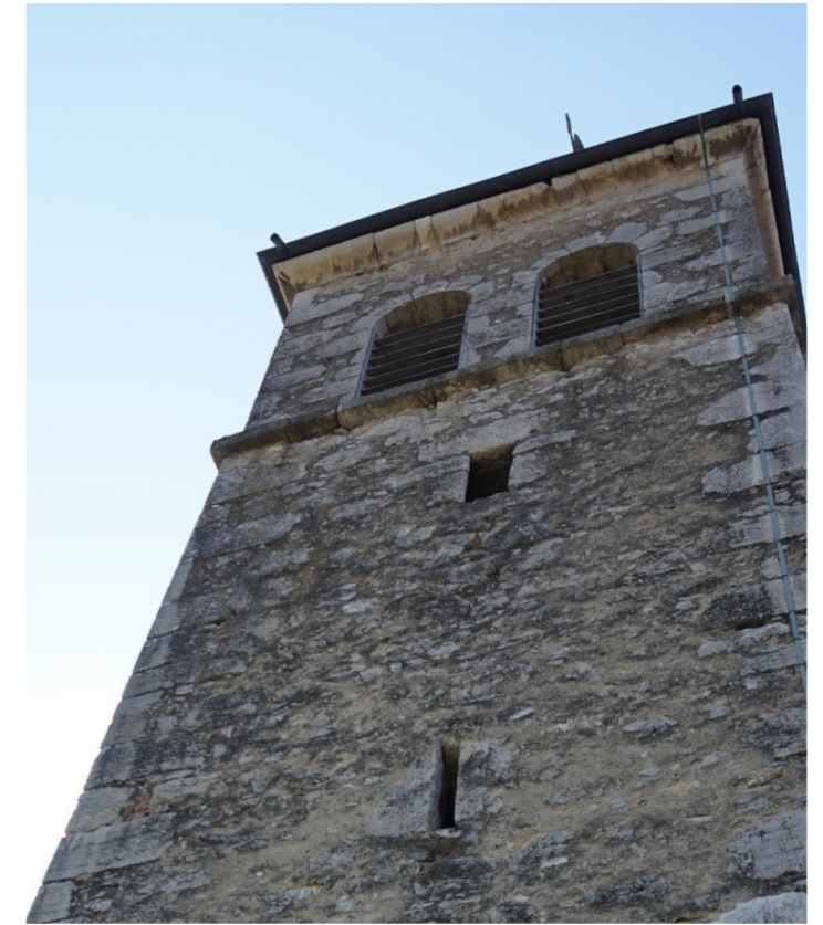
FAÇADE NORD - ZOOM CLOCHER - PHOTO AVRIL 2019, CR
