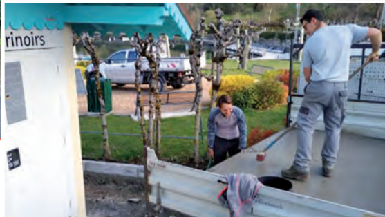
Pose de bordures aux toilettes publiques du port.
