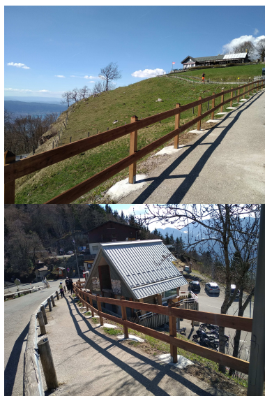
Rénovation Barrières au col de la Forclaz
