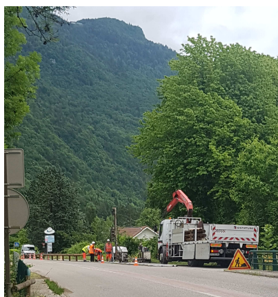
Réfection des barrières de la
