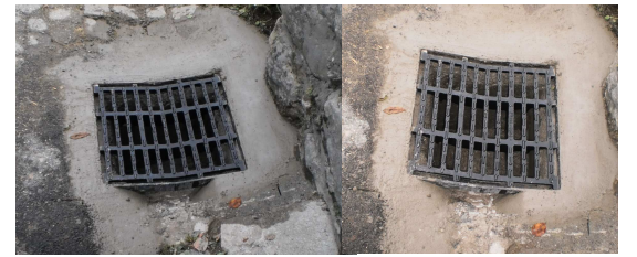
Réparation grilles eaux pluviales à Montmin
