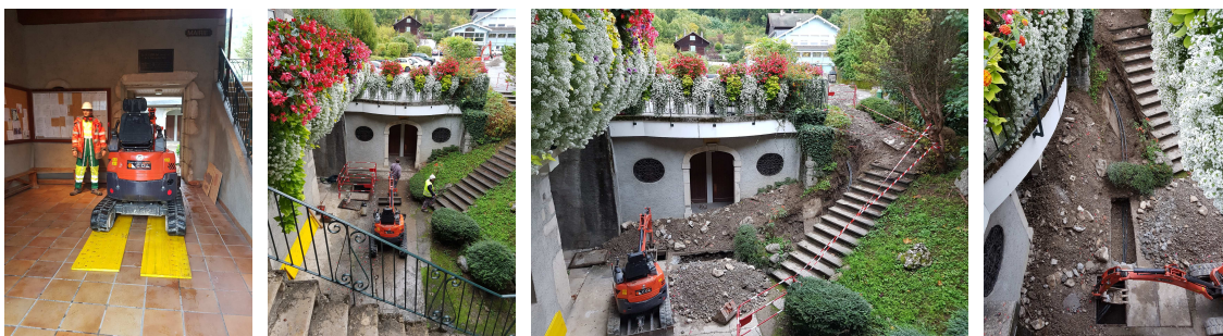
Travaux pour la mise en place de la fibre optique
