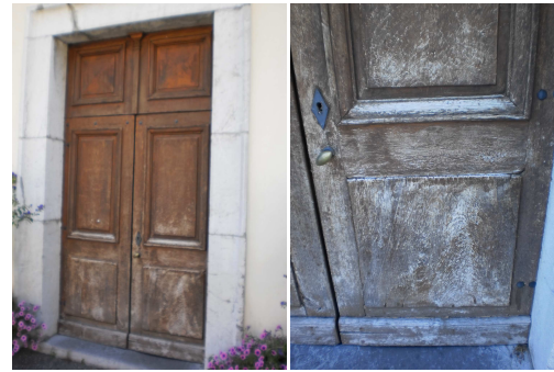
Rénovation porte église de Montmin
