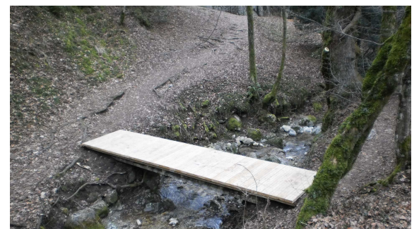
Réfection petit pont pour accéder au pont des Fées
