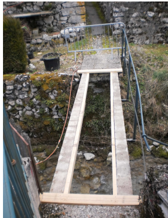
Réfection passerelle située dans le village d'Angon
